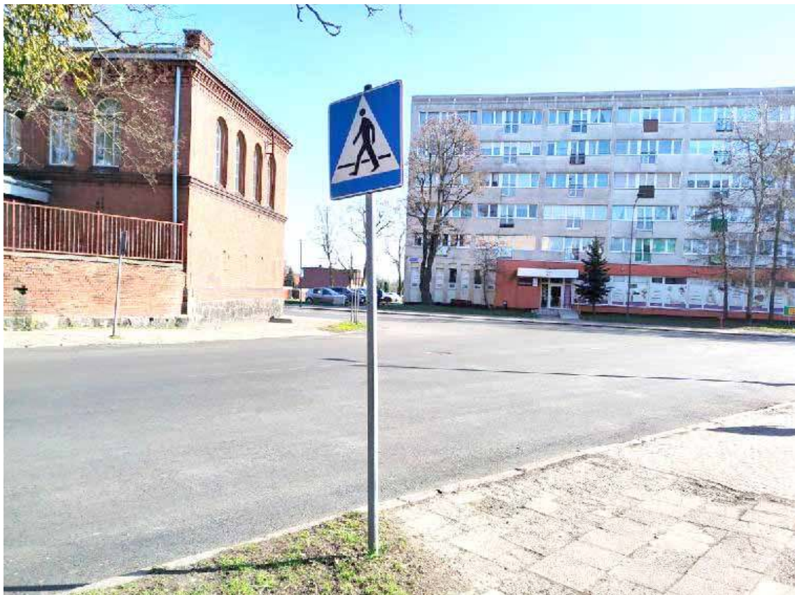
Przejście u zbiegu ulicy Śląskiej i Staszica - jest znak, ale nadal brak odmalowanych pasów
