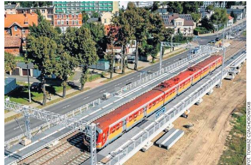
Nakło Zachodnie - przystanek budowany jest przy linii kolejowej Kutno - Piła Główna, w sąsiedztwie przejazdu kolejowo-drogowego
