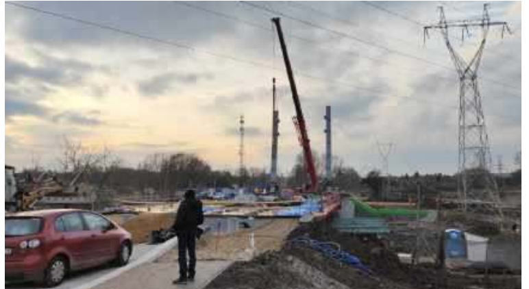
Choć drogowcy nie próżnują na budowie mostu na ul. Żeglarskiej zostało jeszcze sporo do zrobienia
