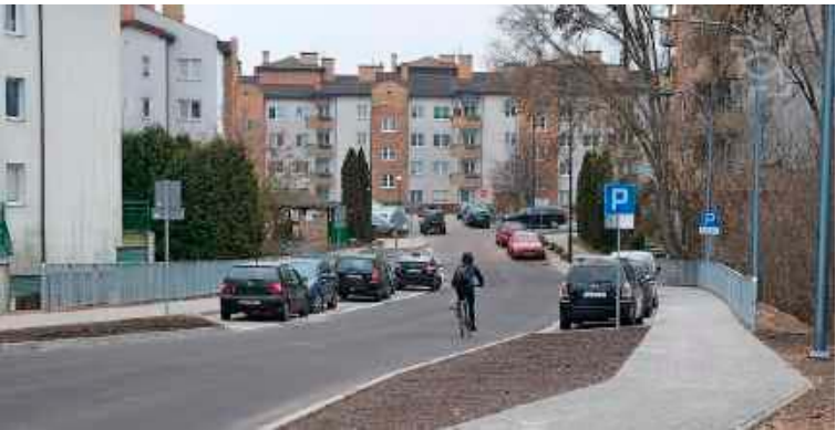
Nowa ulica łącząca ul. Milenijną z ul. Szelińskiego odkorkuje tutejsze osiedle mieszkaniowe
