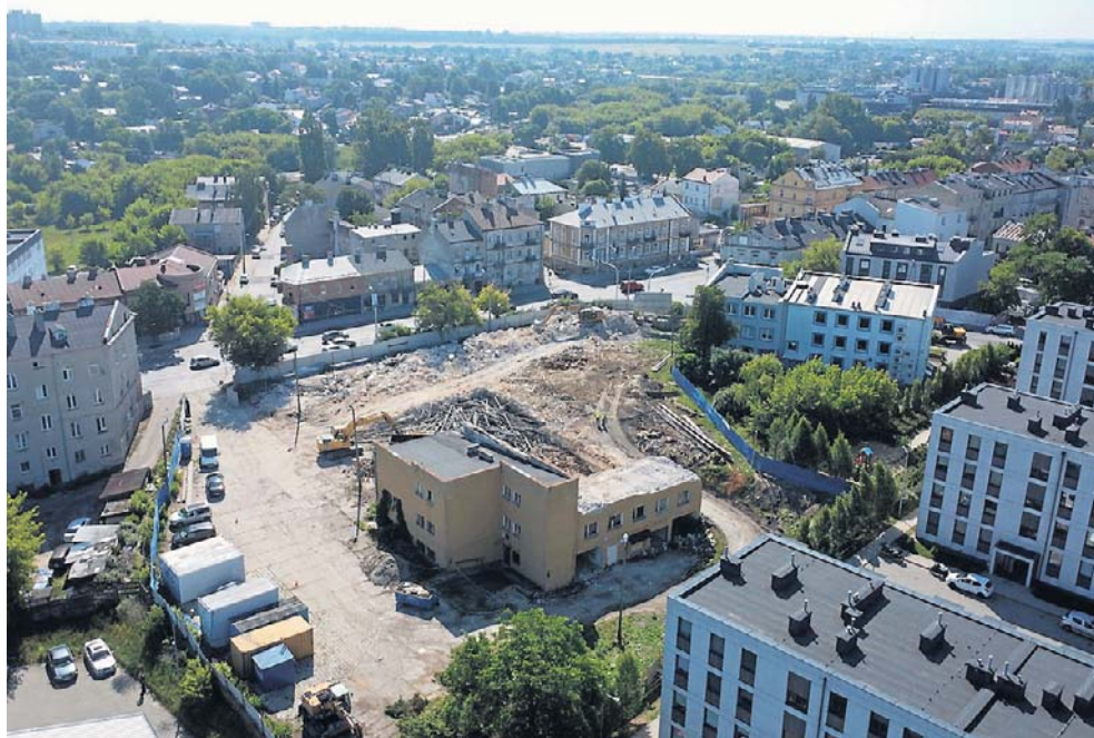
Miejsce rozbiórki od ul. Kunickiego oddziela blaszany parkan. Większość starego obiektu już obrócono w gruz
