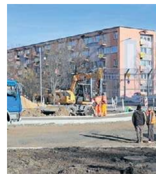
Prace przy budowie ronda turbinowego w Radomiu.
