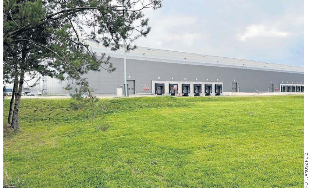
Hala na radomskim Wincentowie. Teren należy do specjalnej strefy przemysłowej przygotowanej przez miasto Radom.
