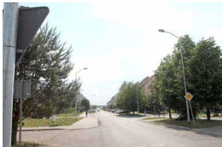
Ogłoszono przetarg nieograniczony na budowę chodnika i kanalizacji deszczowej na odcinku ul. Niepodległości od skrzyżowania z ul. Powstańców Warszawy do granic miasta
