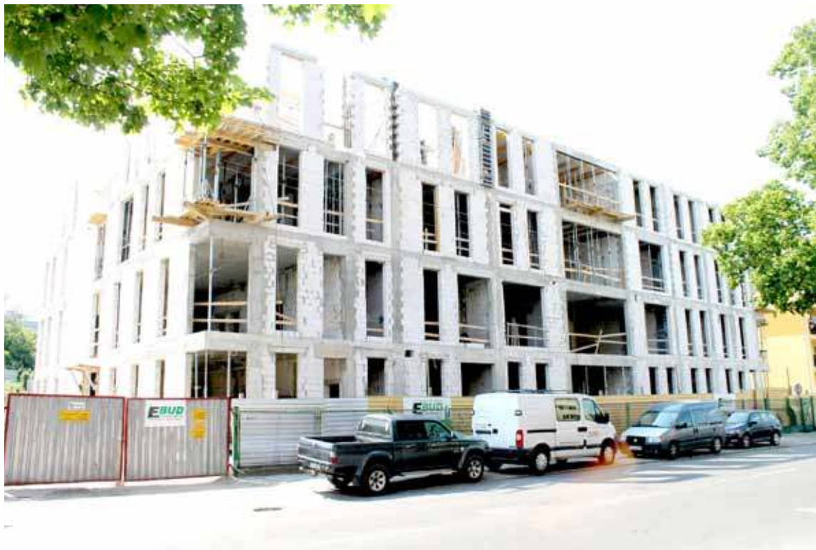
Nowa siedziba sądu przy ulicy Okrzei
