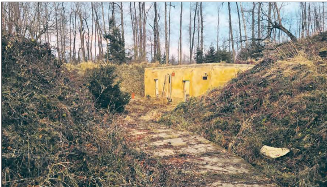
Jeden z budynków otoczony wałem ziemnym. Tu zapewne składowano amunicję.
