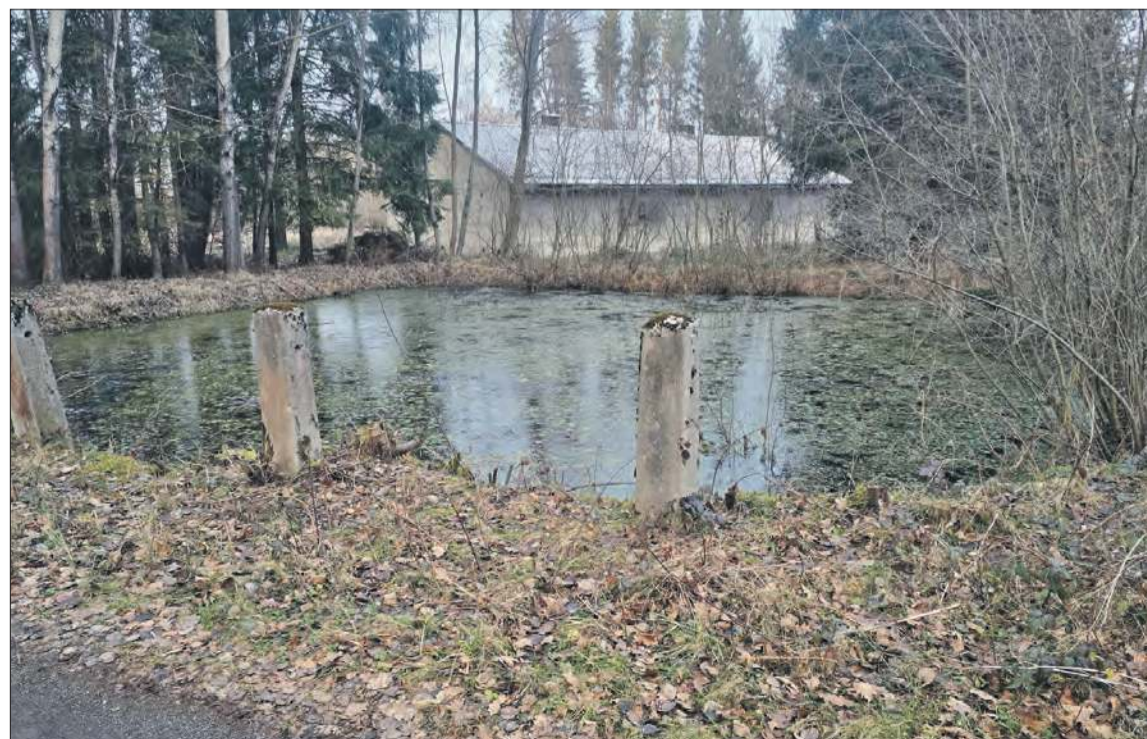
Na terenie Muni znajdowało się sporo obiektów ochrony przeciwpożarowej, w tym zbiorniki z wodą.
