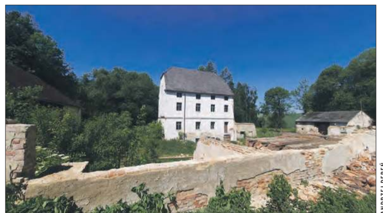
Widok na budynek młyna i wyburzone w całości lub fragmentach obiekty wokół niego (lato 2024)
