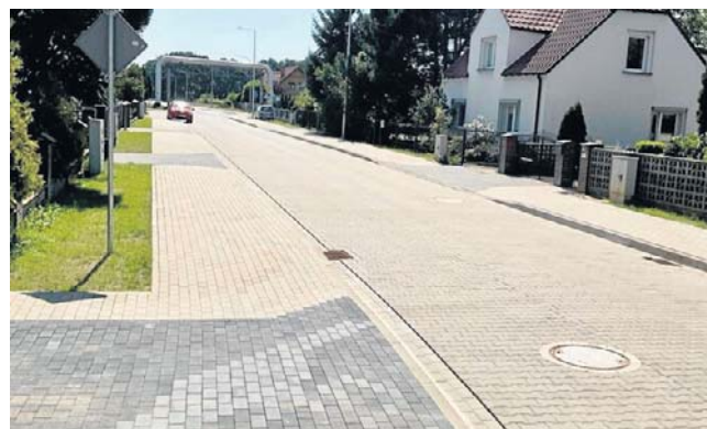
Pierwszy etap prac w rejonie ul. Ślósarskiego, ul. Kanałowej i ul. Granitowej zakończono w ubiegłym roku
