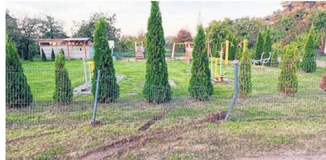
Tak wygląda uszkodzone ogrodzenie przy świetlicy wiejskiej w Sątopach
