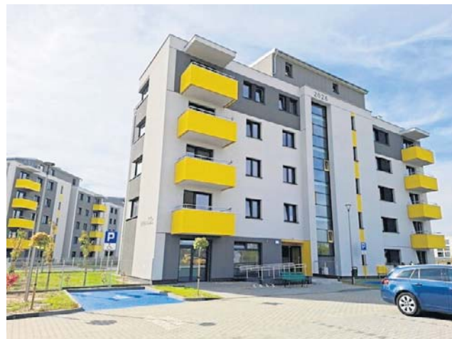
Jest to pięciokondygnacyjny obiekt z jedną klatką schodową wyposażoną w dźwig osobowy
