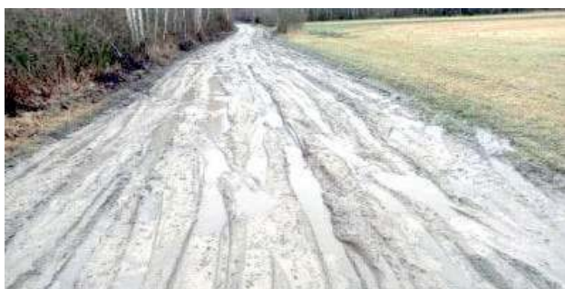
Na drodze z Suchocina do Kownatek robi się takie błoto, że traktory muszą wyciągać ugrzęźnięte samochody, a kiedy jest sucho, droga jest pełna głębokich dziur
