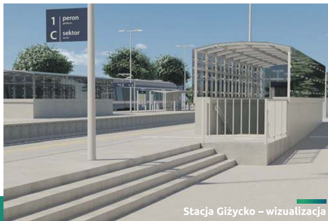
Budowa przejścia podziemnego w Giżycku
