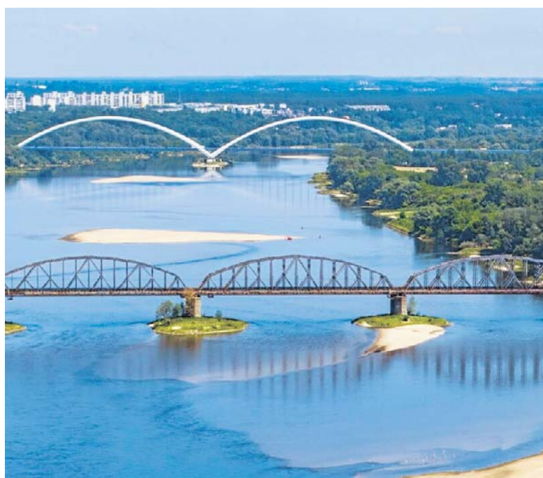
Most kolejowy i „nowy” most drogowy w Toruniu
