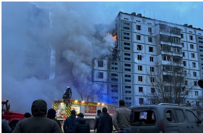
Зруйнований під'їзд будинку в Умані. Фото з фейсбук-сторінки міністра МВС Ігоря Клименка
