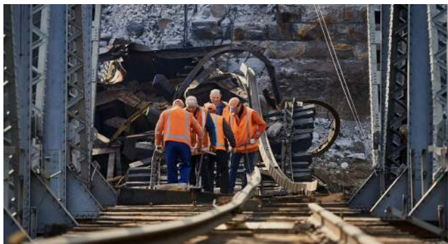
Відновлення зруйнованого залізничного моста в Ірпені, травень 2022. Фото – Таня Довган
