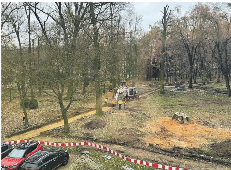
Dzisiaj w parku trwają intensywne prace remontowe. Miały się zakończyć 15 grudnia tego roku, ale już widać, że wykonawca nie dotrzymał terminu
