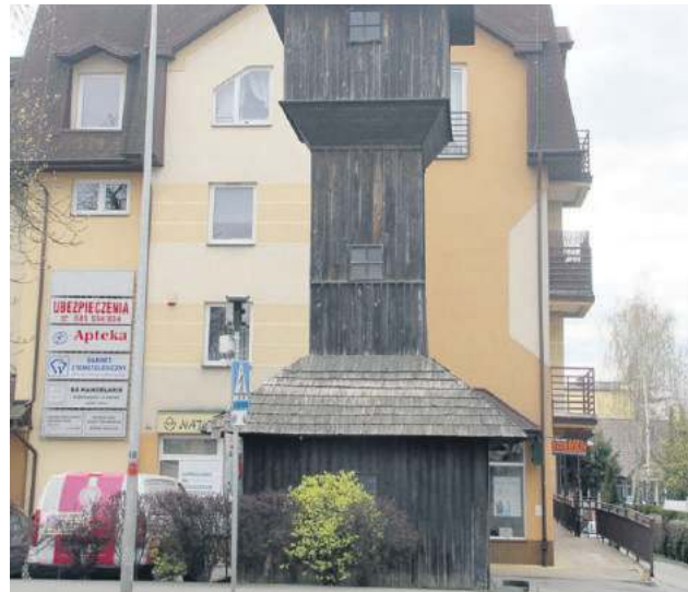
Drewniana wieża ciśnień w sąsiedztwie ulicy Zacisze
