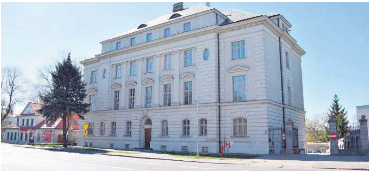
Nieruchomość przy ul. Partyzantów 10 miasto przejęło w 2019 r. od Skarbu Państwa. Jest to trzykondygnacyjny budynek proj. Stanisława Filasiewicza, którego budowę rozpoczęto w 1925 r. Dwa lata później otwarto w nim oddział Banku Polskiego. We wrześniu 1939 r. przywieziono tu część złota Skarbu Państwa. Po wojnie w budynku swoją siedzibę miała komendantura miasta i NKWD. W piwnicach był areszt. Już w 1945 r. funkcjonował oddział Narodowego Banku Polskiego. Od 2003 r. orzekał tam Wydział Cywilny Sądu Okręgowego w Zamościu oraz Wydział Gospodarczy Sądu Rejonowego w Zamościu.
