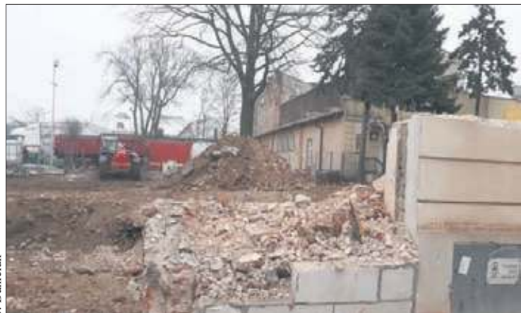
Przy ulicy Kościuszki 3b powstają mieszkania w programie „Mieszkanie na start” oraz siedziba Mediateki Książnicy Płockiej
