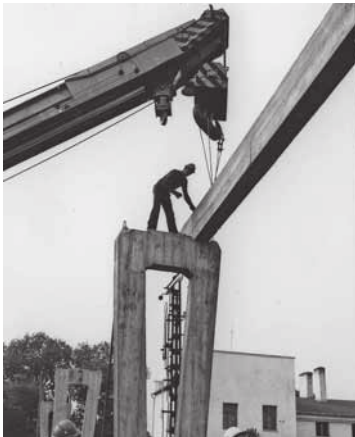
Budowa kładki nad torami
