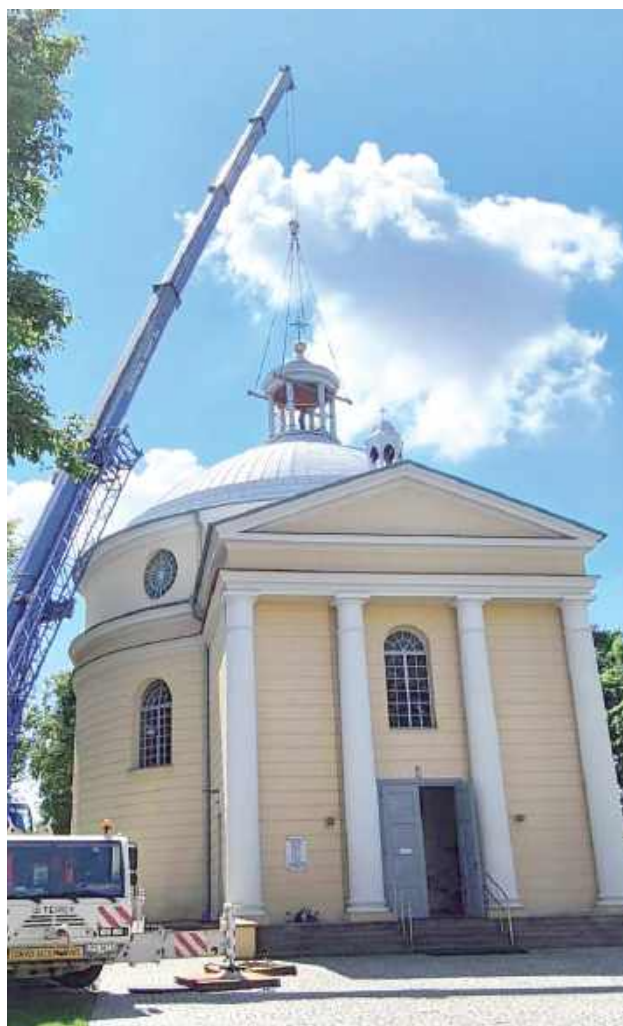
Remont dachu na żyrzyńskim kościele będzie kosztował blisko 1 mln zł
