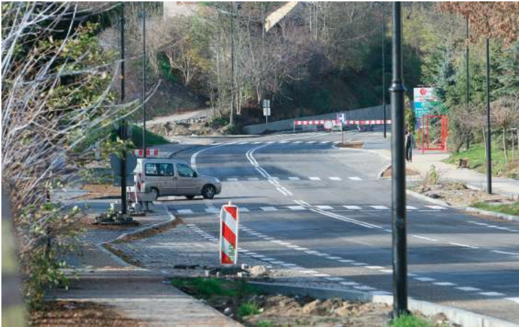
Przebudowa ulicy Kalinowszczyzna miała potrwać do czerwca przyszłego roku, ale drogowcy tak przyłożyli się do pracy, że inwestycja będzie gotowa pół roku przez terminem
