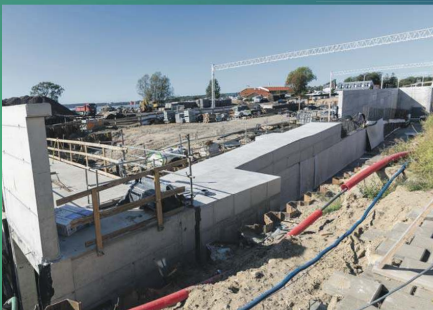
Budowa przejścia podziemnego
