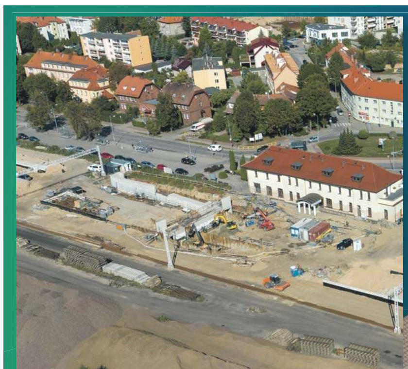
Przebudowa stacji Giżycko
