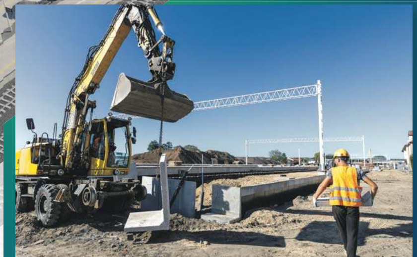
Montaż ścian peronowych
