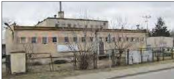
Widok nieruchomości budynkowej od strony ul. Grunwaldzkiej
