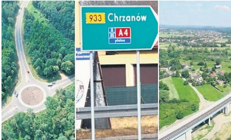
Trwają przygotowania do budowy drugiego etapu Drogi Współpracy Regionalnej. Pierwsza jej część to północna obwodnica Oświęcimia
