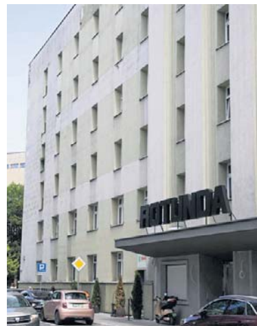
W Centrum Kultury Rotunda trwa wielki remont
