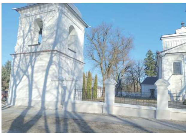
Dzwonnice i parkan zostały wyremontowane
