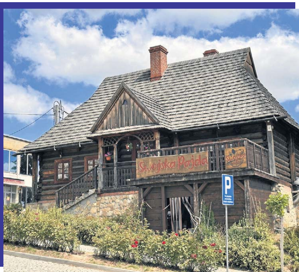
Przykład drewnianej zabudowy w Pruchniku.
