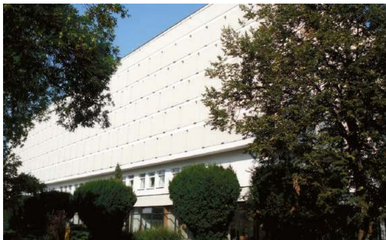
Biblioteka Główna UMCS znalazła się wśród 28 budynków walczących o nagrodę w kategorii „Budynek po termomodernizacji” Obiekt do konkursu zgłosił wykonawca, EDACH Sp. z o.o.
