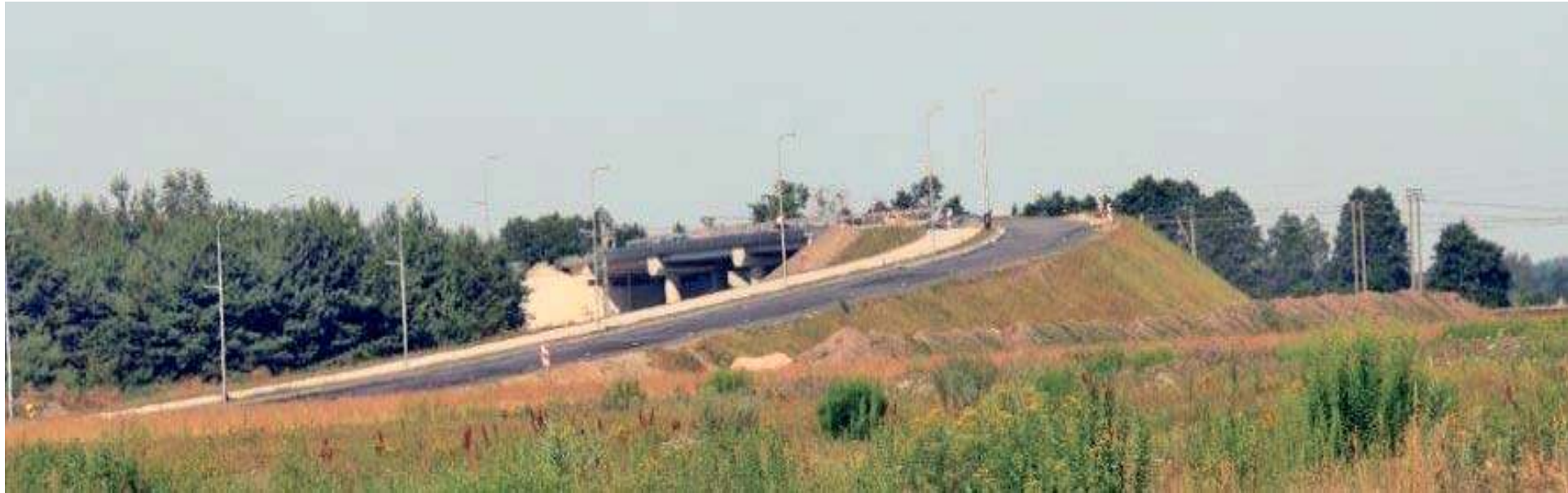
Obwodnica wraz z wiaduktem to bardzo ważna inwestycja z punktu widzenia mieszkańców całego powiatu nowosolskiego
