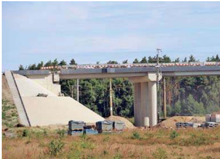
Obwodnicę wykonuje firma Budimex
