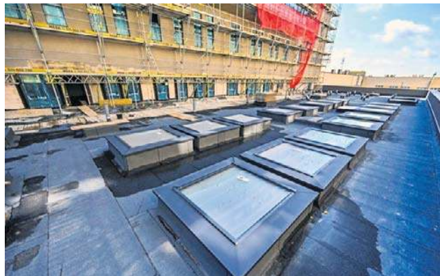
Prace na budowie wstrzymano w 2024 roku
