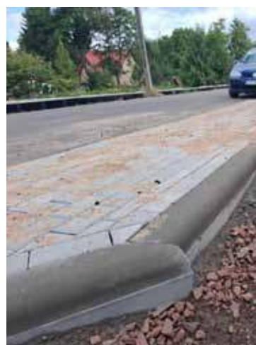
Tak z bliskiej perspektywy wyglądają krawężniki na przebudowanej drodze w Skalinie
