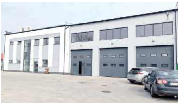
Oprócz tego powstał także budynek z warsztatem i pomieszczeniami socjalnymi dla pracowników
