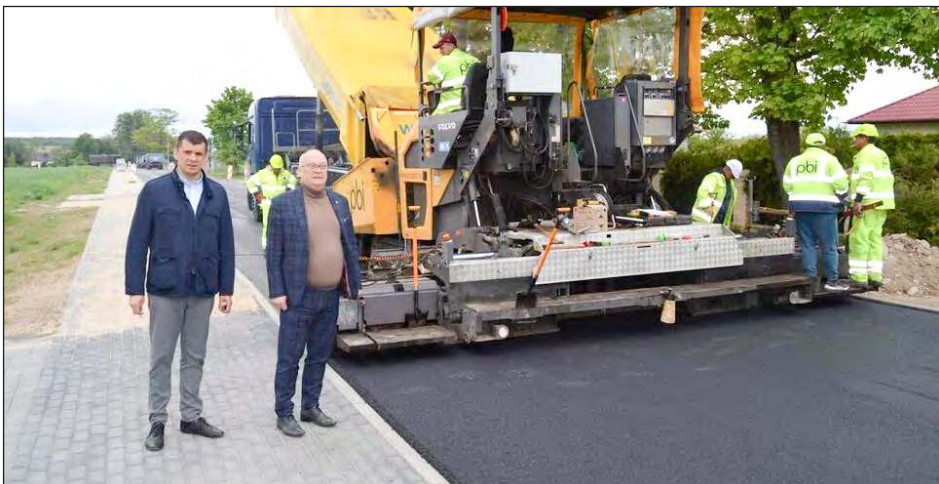
■ Wykonawca rozpoczął układanie warstwy ścieralnej nawierzchni jezdni
