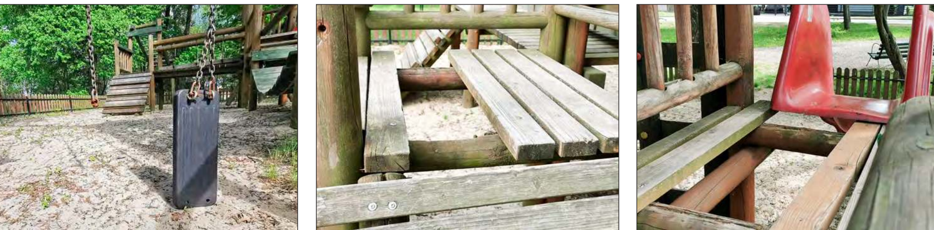
❖ Uszkodzona huśtawka nie nadaje się do użytku❖ - Dziury w podestach są takie, że dziecko może wpaść i połamać sobie nogi - przestrzega nasz Czytelnik
