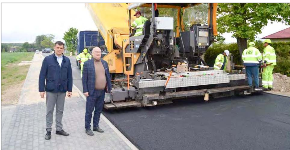
■ Wykonawca rozpoczął układanie warstwy ścieralnej nawierzchni jezdni
