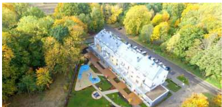
STBS wybuduje kolejny blok mieszkalny na Osiedlu Lotnisko
