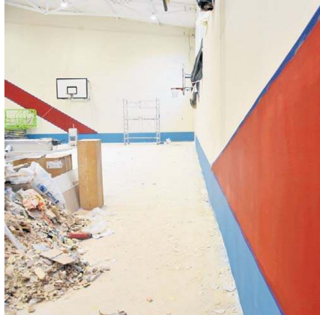
Wszystkie zaplanowane prace remontowe na sali gimnastycznej mają się zakończyć 10 grudnia
