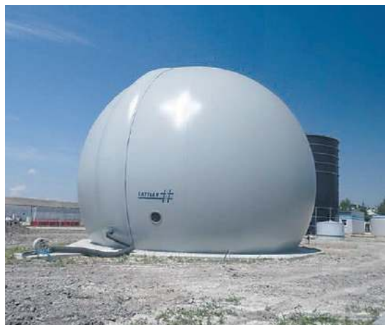
Zbiornik biogazu 1000 m sześć
