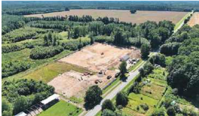
Budowa centrum turystyczno rekreacyjnego w Strzekęcinie
