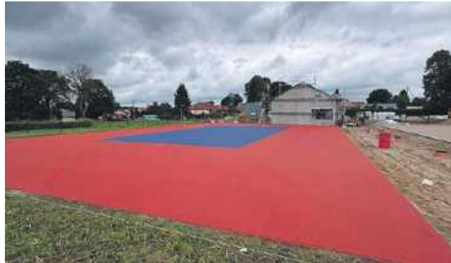
Budowa orlika w Konikowie
