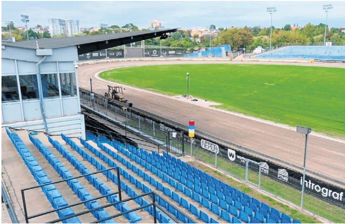
Stadion żużlowy przy Al. Zygmuntońskich. Zwycięska firma na wykonanie zlecenia będzie miała 33 miesiące od momentu podpisania umowy
