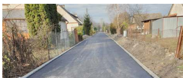
Najważniejszą ubiegłoroczną inwestycją gminy Lubycza Król. była przebudowa drogi w Nowosiólkach Kardynalskich.
