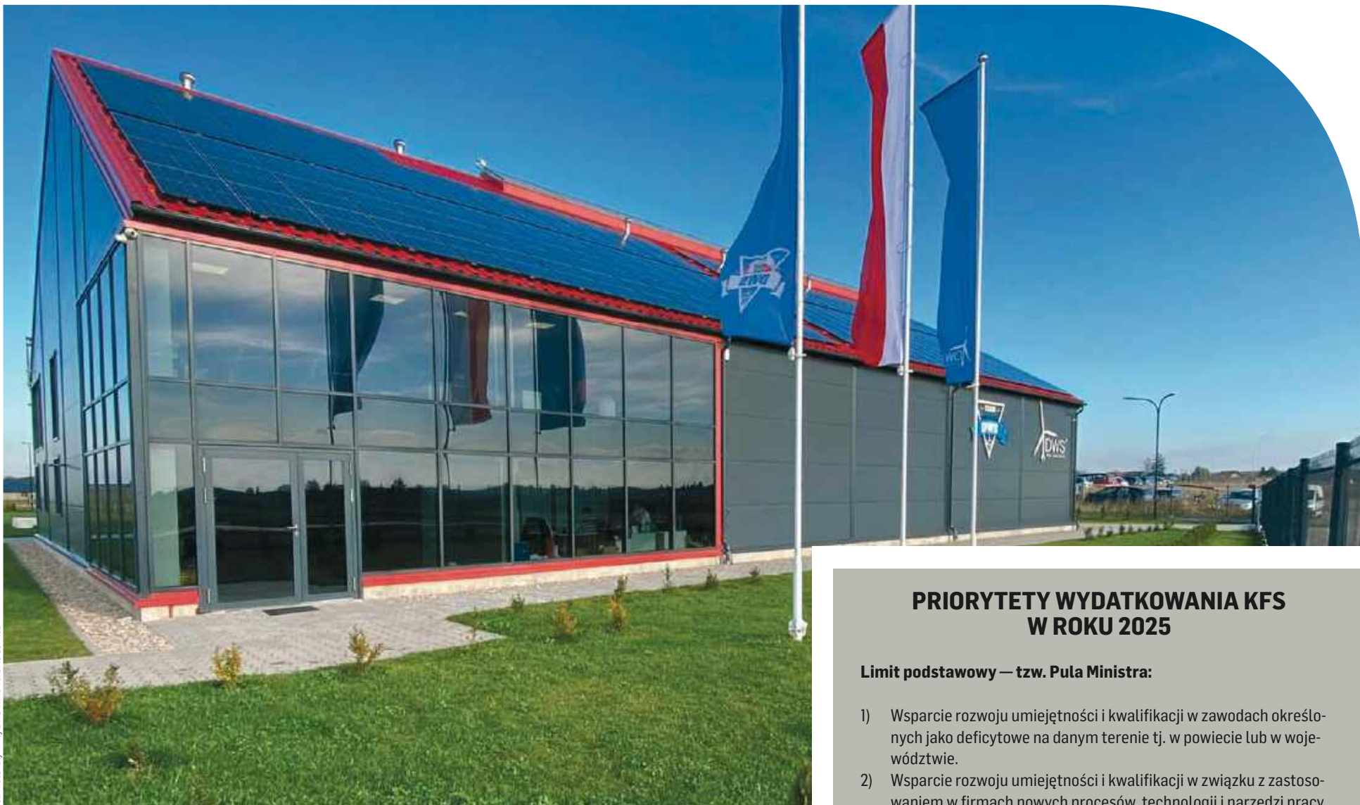
Fot. materiały firmy DWS Wind Turbine Service
