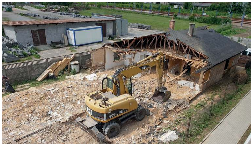
Wyburzanie budynków widziane z wiaduktu
