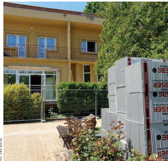
Okna już zostały wymienione
