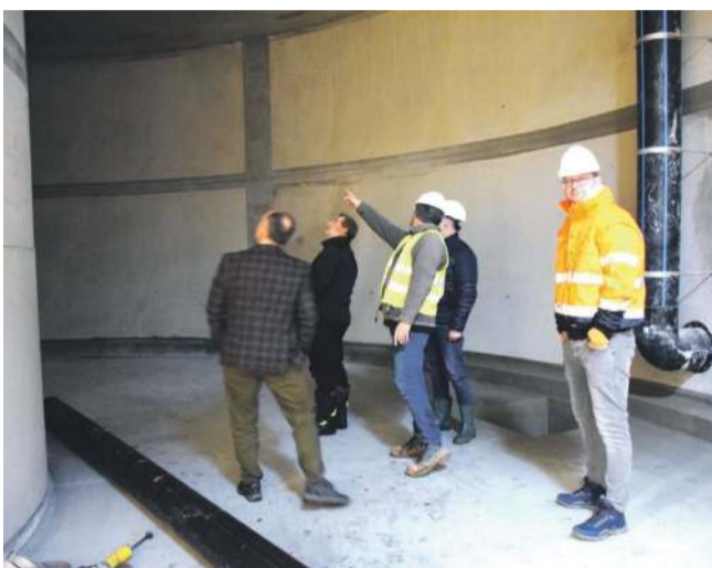
Zbiornik wody w budowanej stacji uzdatniania wody w Machnicach
