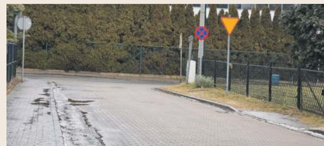
Po drugiej stronie jezdni jest chodnik z kostki
