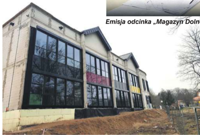
Szkoła Podstawowa w Wiszni Małej w trakcie budowy
