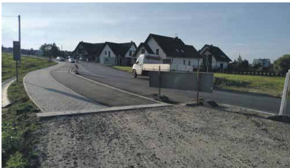
W tym miejscu kończy się ciąg pieszo-rowerowy w Zaskalu. Dalszą budową chodnika i ścieżki oraz remontem peronów zajmie się kolej.
