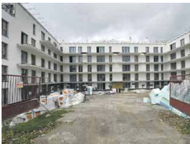
Ponad połowa z 241 apartamentów w powstającym na Szymonach budynku jest już sprzedana.
