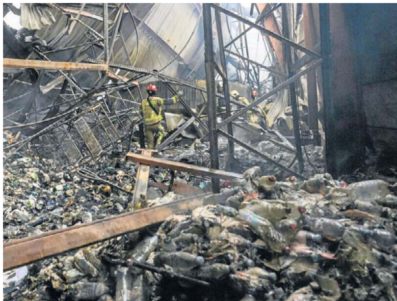
Kilka dni temu po uderzeniu rosyjskiego pocisku balistycznego zniszczony został magazyn żywności w Kijowie
