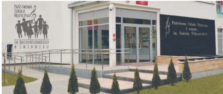
Budynek nowej szkoły
