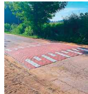
Próg po odbudowaniu
