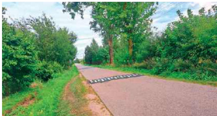
Próg przed uszkodzeniem
