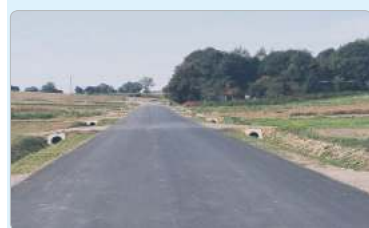
Rozbudowa drogi powiatowej Żółkiewka - Celin
