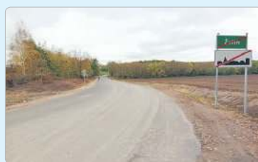
Przebudowa drogi powiatowej nr 3122L Łopiennik - Żulin
