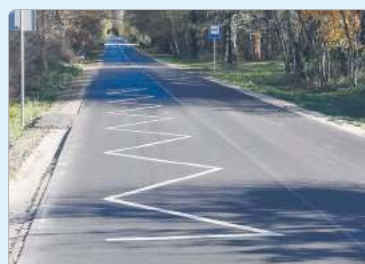
Remont drogi powiatowej Łopiennik - Żulin - Rejowiec
