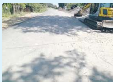
Rozbudowa drogi powiatowej Suszeń - Majdan Borowski Pierwszy - Suche Lipie
