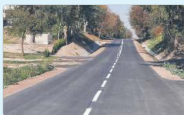
Rozbudowa drogi powiatowej Wólka Orłowska - Kalinówka - Skierbieszów
