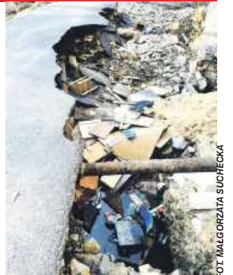
Na drogach brakuje asfaltu, ale walają się rzeczy ze zniszczonych domów
