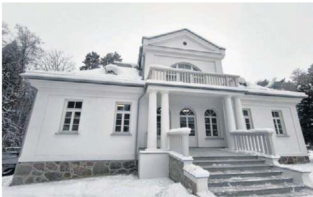
Po odrestaurowaniu obiektu, już widać piękno dawnego dworku
