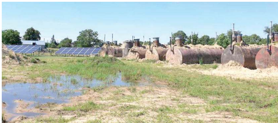
Firma EKO-Bug zajmuje się ujęciem wody, oczyszczalnią ścieków oraz budową przyłączy kanalizacyjnych w gm. Terespol
