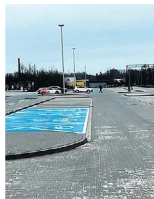
Parking pomieści 85 samochodów
