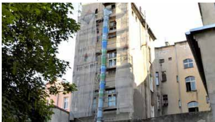
Dzięki pracom remontowym kamienica przy ulicy Czarnieckiego 19 odzyska dawny blask
