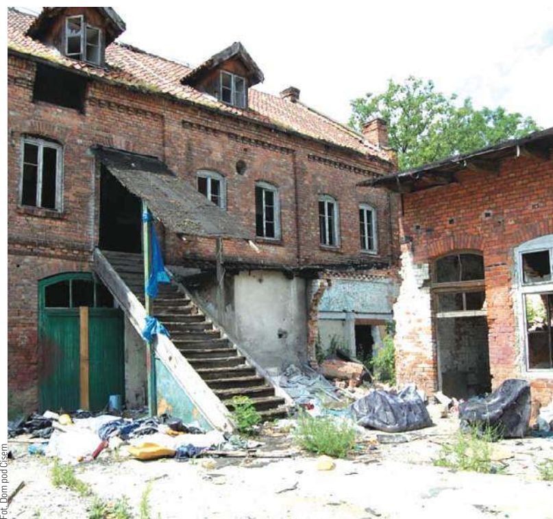
Tak wyglądał budynek w 2014 roku
